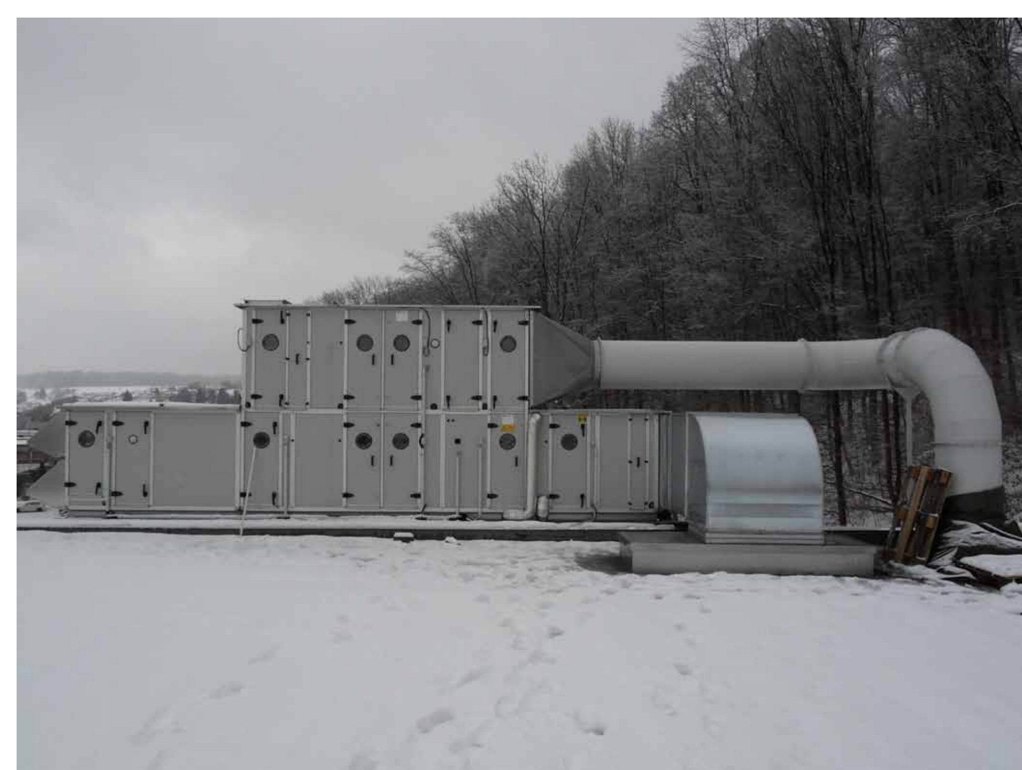
Zentrales Lüftungsgerät auf dem Dach Maschinen-Absaugung
