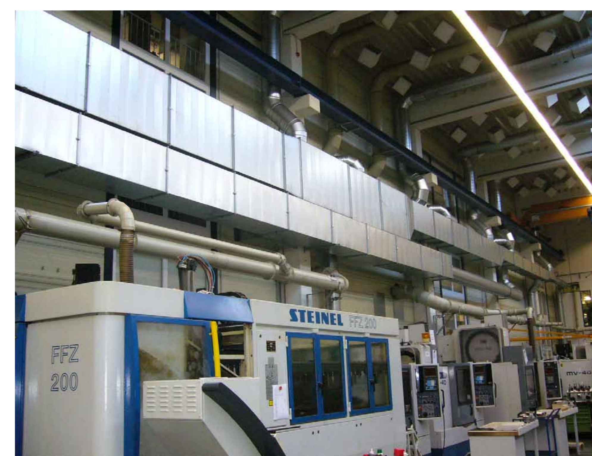
Zentrales Lüftungsgerät auf dem Dach Maschinen-Absaugung
